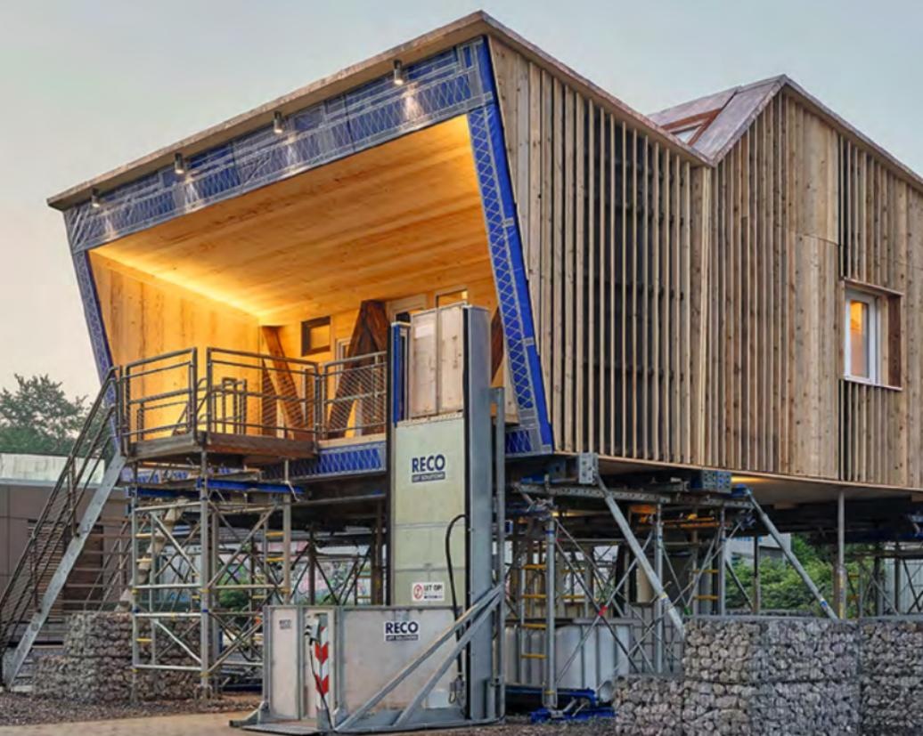
Vom Karlsruher Institut für Technologie entwickelter Aufstockungs-Prototyp »RoofKIT«.
